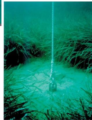
Figura. Ancoraggio installato
