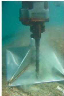
**Figura.** Fissaggio di una piastra con l'uso dei tasselli
