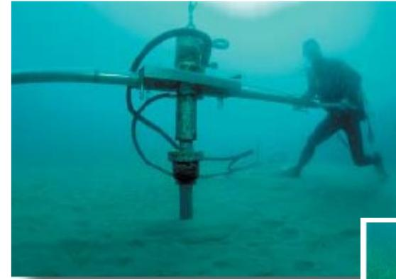
Figura. Installazione di un ancoraggio a vite
