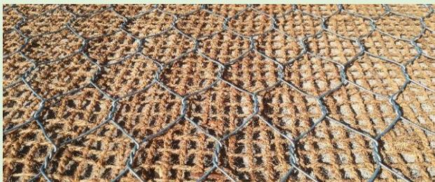
**Figura 1.** Biostuoie R.E.C.S.® - Cocco *in situ* ad un anno dal trapianto. In alto a sinistra le stuoie sono rinverdite con talee (si distinguono i nuclei di ricolonizzazione); in alto a destra stuoia rinverdita con germogli; in basso a sinistra dettaglio della biostuoia.
